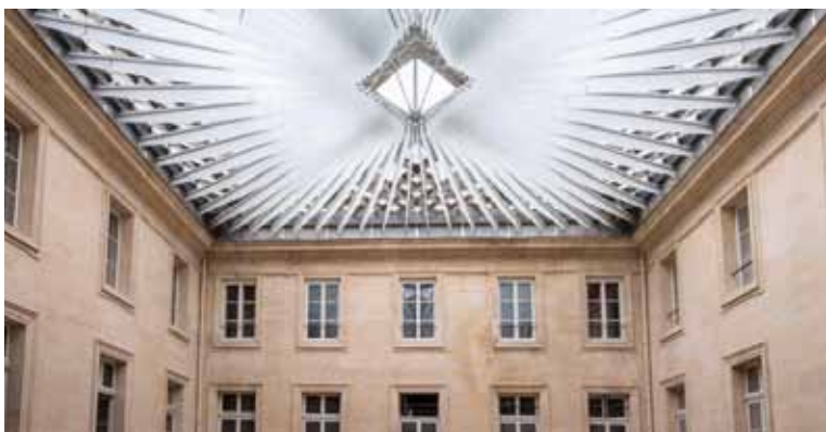
La cour de l'Intendant de l'Hôtel de la Marine vient de se doter d'une verrière diamant de 300m 2 ©HDA-Nicolas Trouillard
